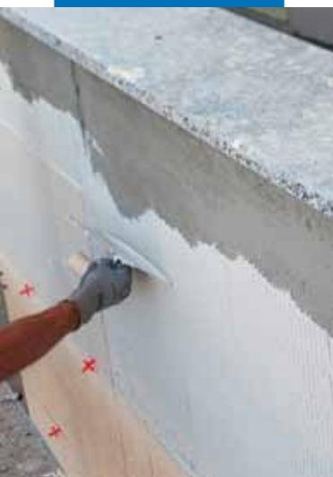
Lepení v exteriéru na fasádu: nanášení lepidla na podklad
