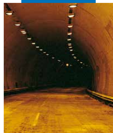
Nanášení bílého Planisealu 88 nástřikem v dálničním tunelu
