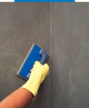
Konečná úprava houbovým hladítkem
