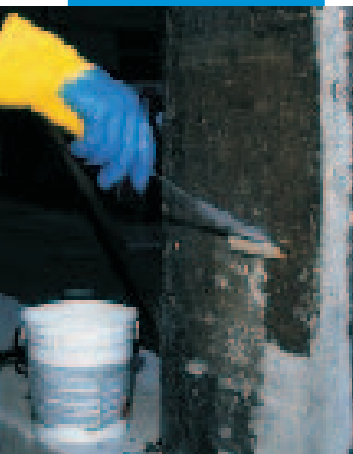
Nanášení druhého nátěru MAPEWRAPu PRIMER 1
