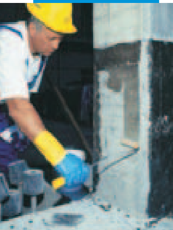
Nanášení prvního nátěru MAPEWRAPu PRIMER 1
