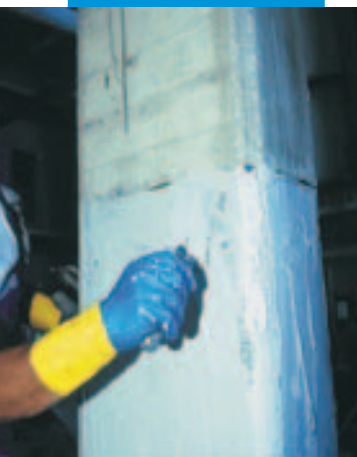
Vyrovnávání MAPEWRAPem 11 nebo MAPEWRAPem 12
