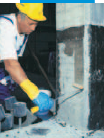
Nanášení nátěru MAPEWRAP Primer 1
