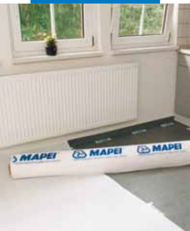
Upevnění Mapetexu na Mapetex-Strip
