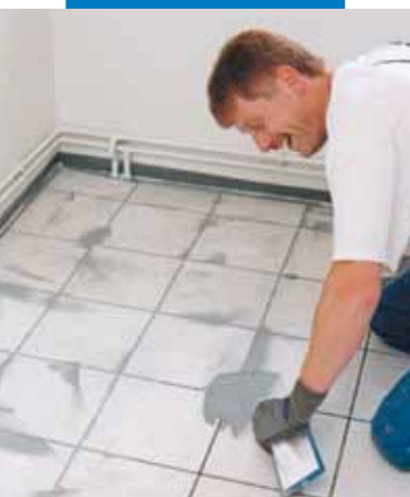
Spárování dlažby Ultracolem Plus
