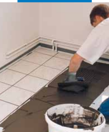
Pokládka keramické dlažby s použitím lepidla Keraquick
