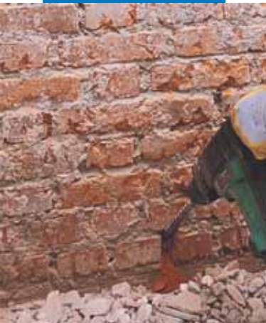
Předvrtání děr ve zdivu
