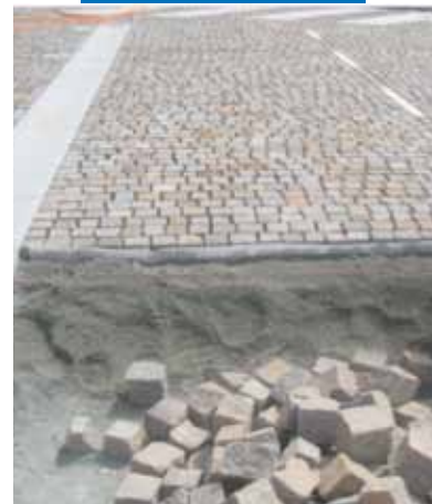
Ukázka umístění dilatační spáry
