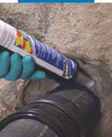
Aplikace Mapeproofu Swell okolo potrubí
