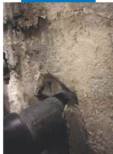
Ohraničení Mapeproofu Swell Mapegroutem T40
