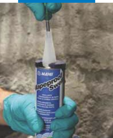
Proděravění ochranné membrány Mapeproofu Swell
