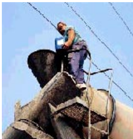
Dávkování přísady do autodomíchávače
