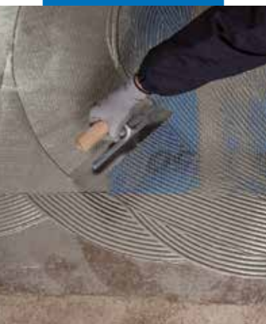
Vložení síťoviny Mapenet 150 na první, ještě čerstvou vrstvu Mapelast ic Turbo
