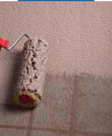
Provádění hydroizolace terasy válečkem
