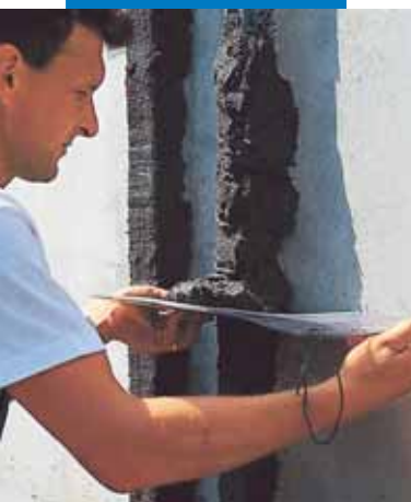
Odstranění přebytečné malty
