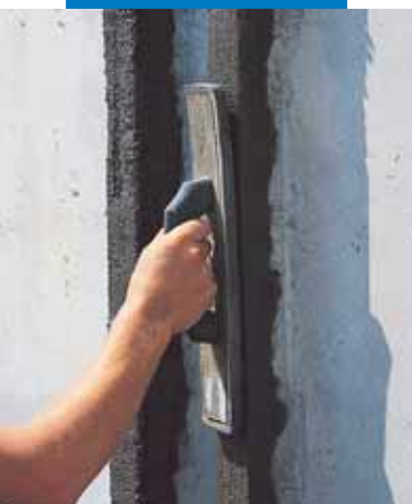
Dokončení pryžovým hladítkem
