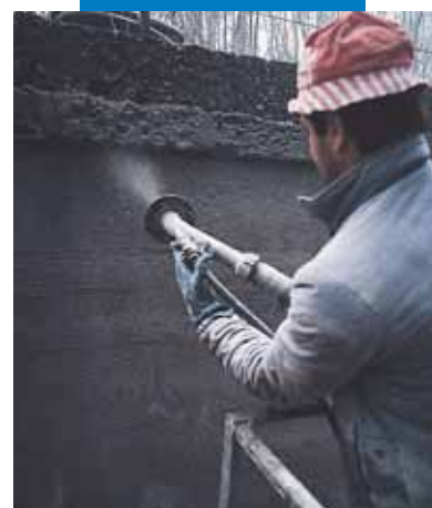
Hydroelektrický kanál Bertini - Robbiate (Como) - Itálie: strojní aplikace
