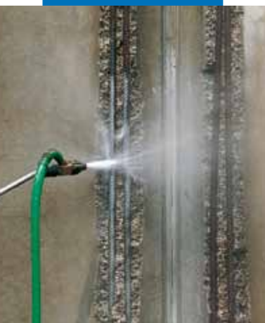
Čištění ocelové výztuže
