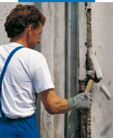
Odstraňování poškozeného betonu
