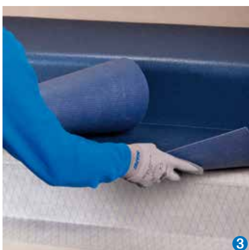
Instalace obvodové lišty z PVC s použitím Mapecontactu
