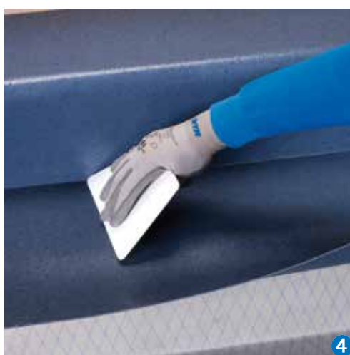
Zhotovení fabionu s použitím Mapecontactu
