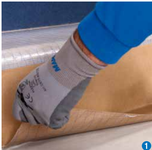
Umístění pásu Mapecontact na podstupnici schodišťového stupně
