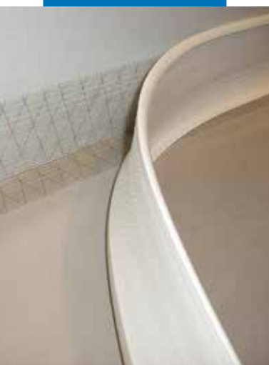
Instalace obvodové lišty z PVC s použitím Mapecontactu
