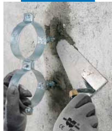
Osazení potrubních objímek s použitím Lampocemu
