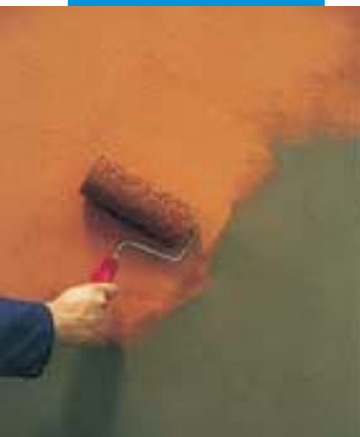
Příklad nanášení Elastocoloru Rasante pomocí buněčného molitanového válečku
