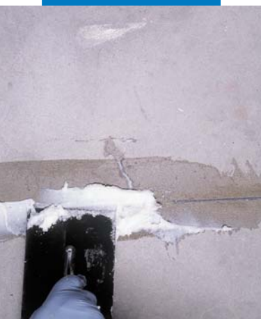
Zapravení spáry Primerem MF s příměsí Additixu PE
